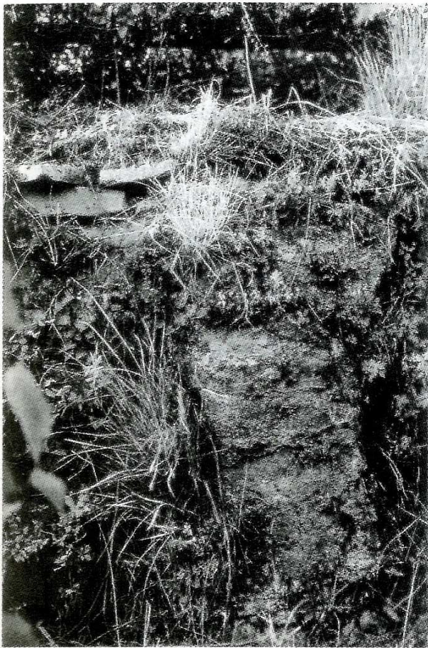
Fig. 8. Sito 12. Struttura muraria in opera cementizia.
