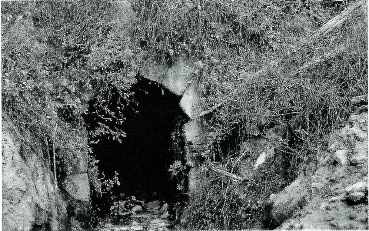
Fig. 7. Sito 10. Ingresso di cunicolo.
